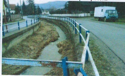
rkm 0,830-0,850 ľB poškodený, nános hr.50-80cm v rkm 0,853 na moste bola ukonč.opr.rímsy v r.2011
