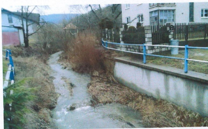
rkm 0,925-0,940 uončenie opravy, v dne nános, po pravej str. dna uloží. betóny zo zbor. op.múra
