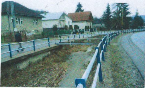
rkm 0,795-0,830 ľB poškodený, nános hr.0,80m
