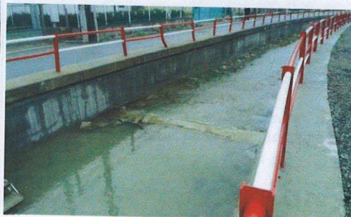
rkm 0,550-0,608 zrealiz. oprava v r.2011 a 2015
