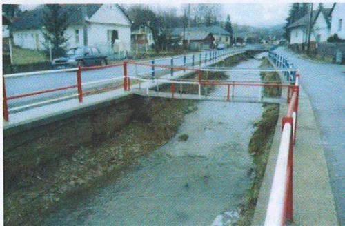
rkm 0,630 oc.lávka, ľavobrežná rímsa so zábradlím opravená v r.2011
