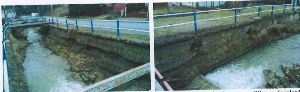
rkm 0,898-0,918, PB op.múr zdevastovaný, dno podomleté, ĽB v op.múre kaverny, pätky podomleté
