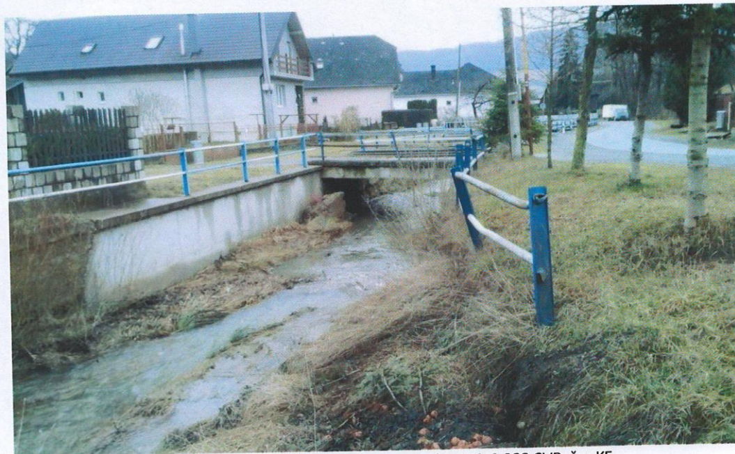
rkm 0,920-0,940 úsek na konci opravy, ĽB op.múr opravený 0,923-0,932 SVP, š.p.KE
