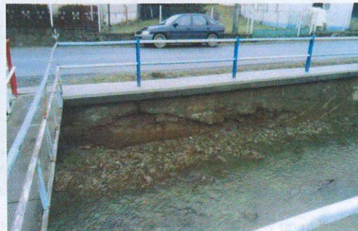
rkm 0,632-0,640 poškodený op.múr, pravá strana rímsa so zábradlím opravená v r.2015
