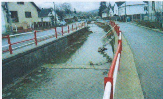
rkm 0,605 začiatok opravy
