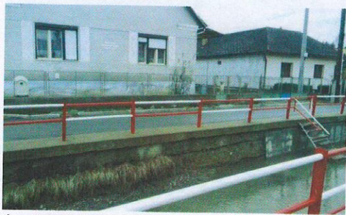
rkm 0,608-0,620 ľB, opr.rímsa r.2011
