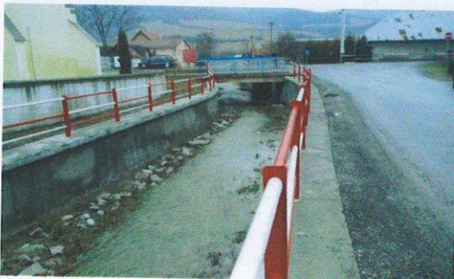
rkm 0,460-0,520 zrealiz. oprava v r.2011 a 2015
