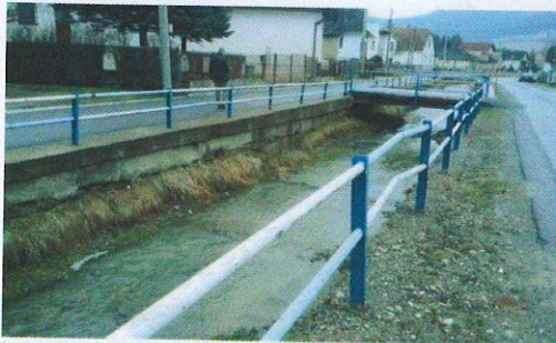
rkm 0,695-0,720 ľB, opr.rímsa, poškod.op.múr
